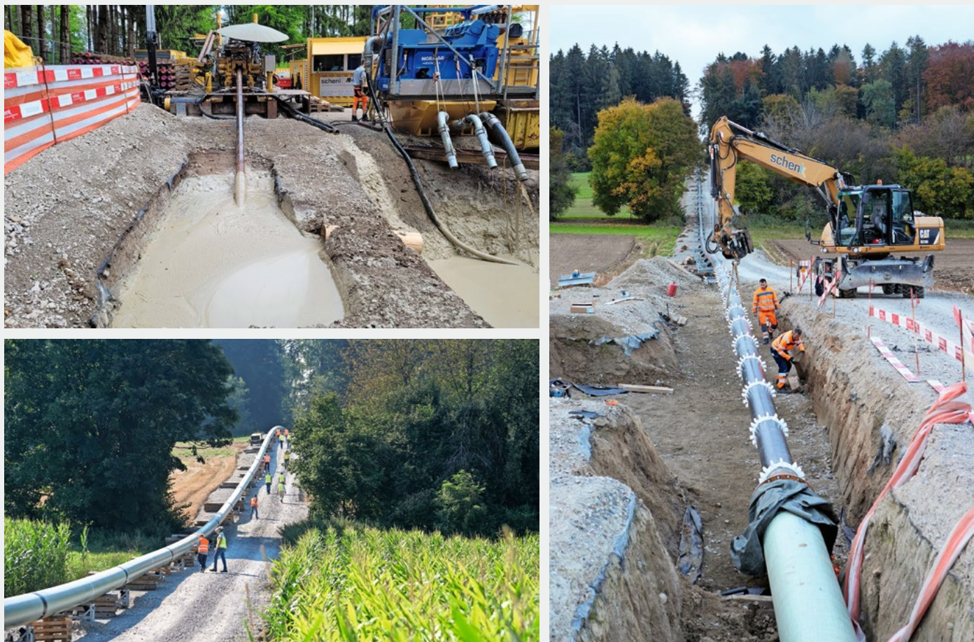
Fig. 6 Impressions des travaux de construction: En haut à gauche: foreuse; en bas à gauche: préparation du tube; à droite: insertion du tube intérieur.
